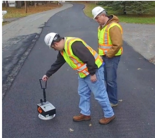
Kvalitetskontroll på ferdig nylagt asfalt
