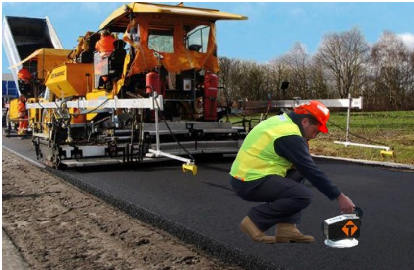
Kvalitetskontroll under legging av ny asfalt parallelt med valsing
